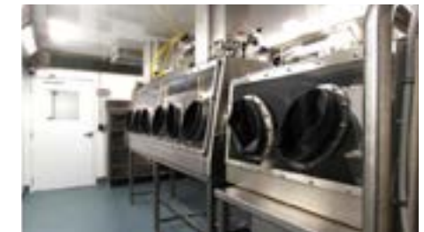
Équipement à l'intérieur du laboratoire ABSL3
